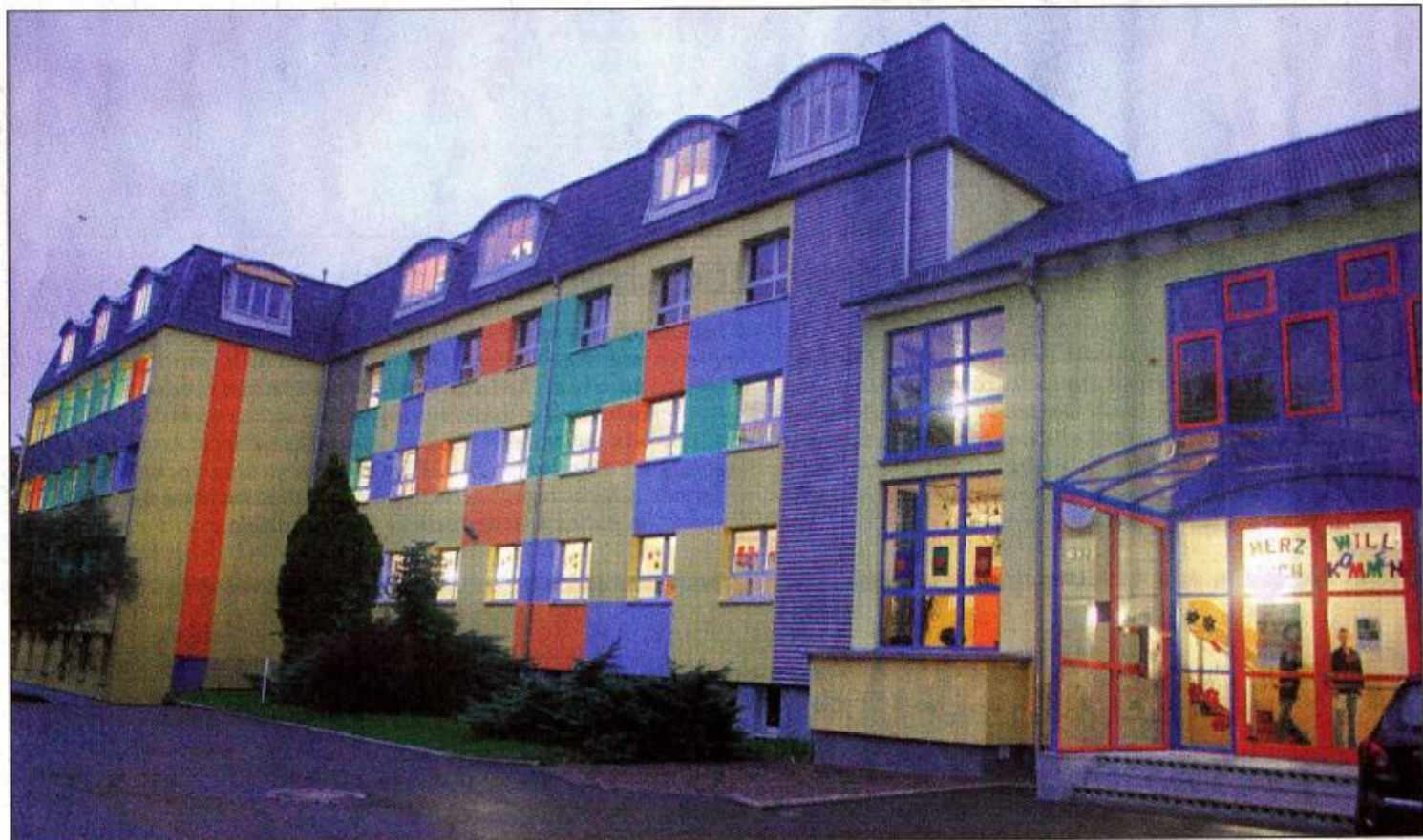
Diese Schule hebt sich durch ihr Äußeres stark von anderen Zweckbauten ab. Die Farbgestaltung folgt neuesten Forschung von Farberstellern, erklärte der Architekt Michael Fuchs zur Einweihung.
